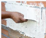
**3.** Coloca cemento adhesivo de contacto distribuyendo uniformemente sobre el muro usando una llana de 1/4" x 1/4". No extienda demasiado el área ya que el adhesivo pierde su humedad.
