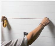
**2.** Marca líneas de apoyo horizontales con un tiralineas sobre la superficie de instalación, para esto, realiza un promedio de la altura de varias piezas de ladrimalla para determinar la separación de las líneas, incluyendo el espesor de la boquilla, aproximadamente de 1 cm.
